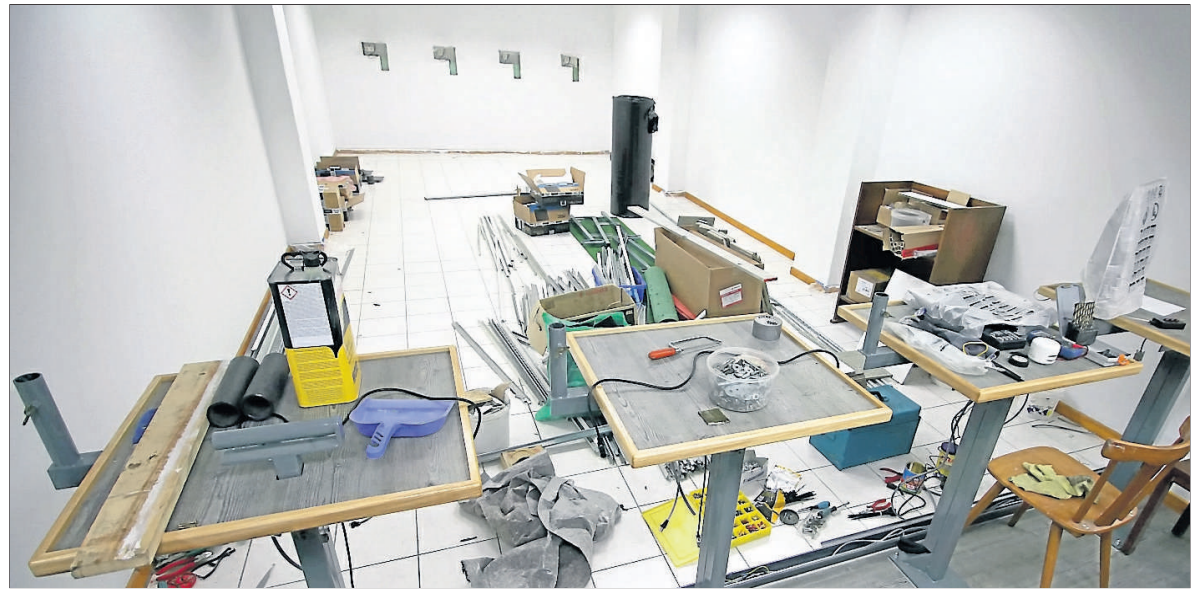
Derzeit ist hier wegen der Bauarbeiten noch kein Sport möglich. Jedoch soll der Zehn-Meter-Stand für Luftdruckwaffen im Freiendiezer Schützenhaus Ende August fertig sein. Die Mitglieder haben ein beträchtliches Maß an Eigenleistung erbracht.
